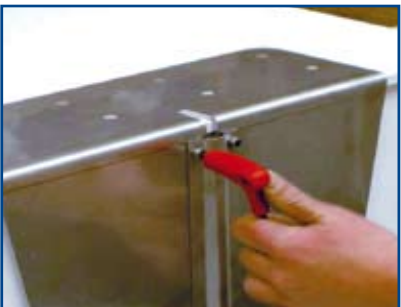
Demonteer de kabelgoot.
