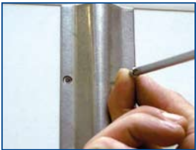
Schroef de kabelgoot vast.
