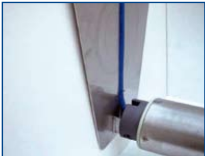
laet de buis zakken over het U-profiel.
