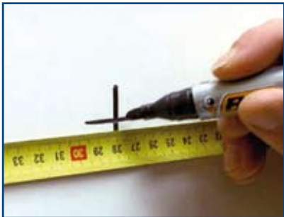
Neem maatvoering van de inhangplaat motorzijde over.
