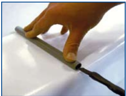
Monteer een elektriciteitsbuis om de kabel onder de randsteen door te voeren (om bij eventuele calamiteiten de motor uit te wisselen).
