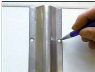
Teken de montagegaten af en boor deze.
