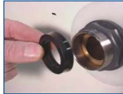
Plaats waterkering aan de putzijde met open zijde naar het bad.
