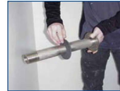
Pakking aanbrengen.
