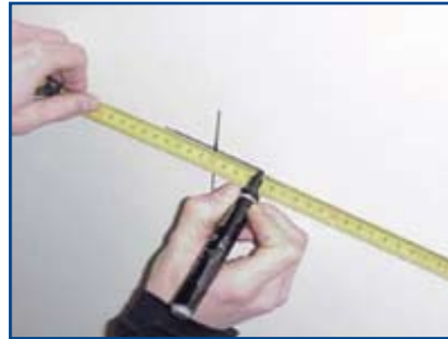
Neem maatvoering van de muurdoorvoer over.
