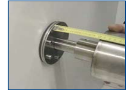
Lengte afstandsbus bepalen en op lengte maken.
