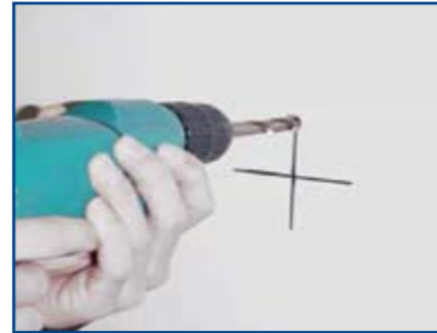
Boor eerste gat met boor \varnothing 11 minimaal 80 mm diep.
