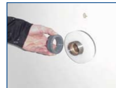
Plaatsen contramoer (handvast).
