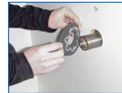
Pakking met kit plaatsen in motorput.
