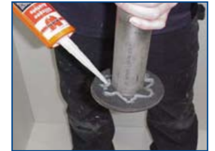
Kit op pakking aanbrengen.
